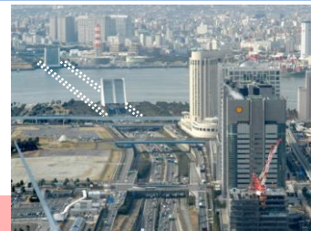
国道357号 東京港トンネル
