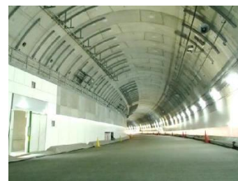
首都高速中央環状品川線 本線シールド 施設施工状況
